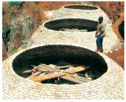
Fig. 5.13: Biogas Plant
